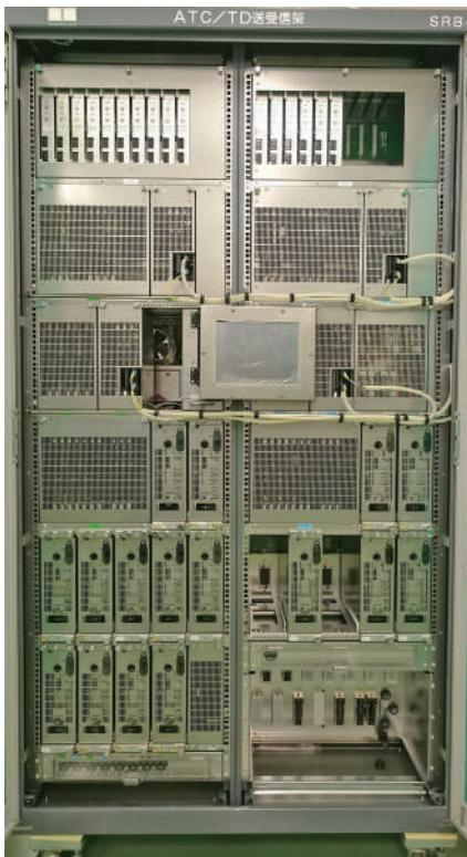
1架内の20台の送信器に対してまとめて共通予備を2台持つ待機系集約方式(N+2方式)のATC地上装置です。20トラック分のATC送信／受信の一括処理が可能です。
